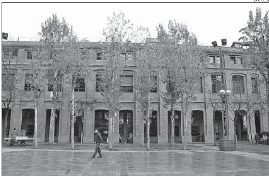
VISTA INTERIOR DE LA PLAÇA DE LA SEDETA
