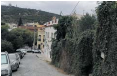
Carrer Manlleu, amb el solar municipal frondós sobre el bloc afectat. Foto: A.B.
